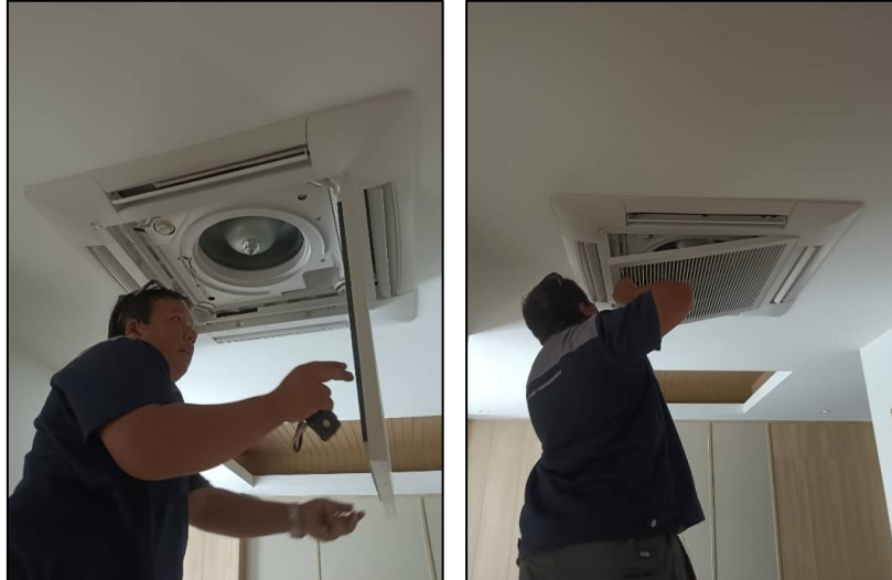
รูปภาพที่ 2.33 ทำความสะอาดเครื่องปรับอากาศ
